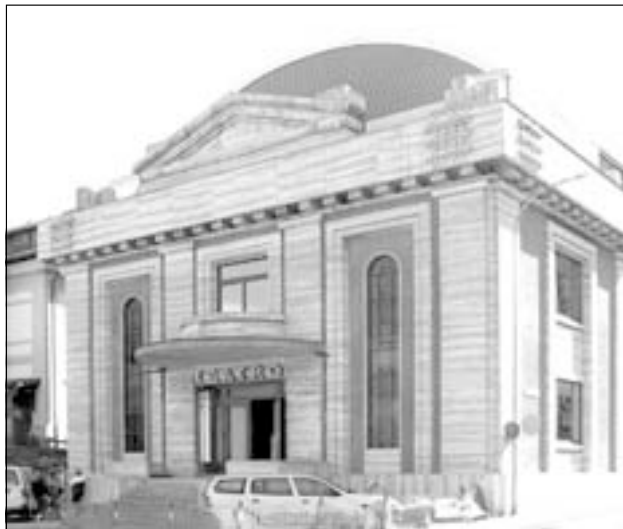
La facciata del restaurato "Cinema Teatro" municipale di Chiasso (foto Riva)
